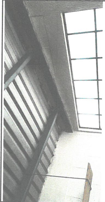
Foto 9: Elevación de techo de cocina.
